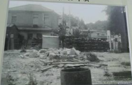
JA建設前の様子
